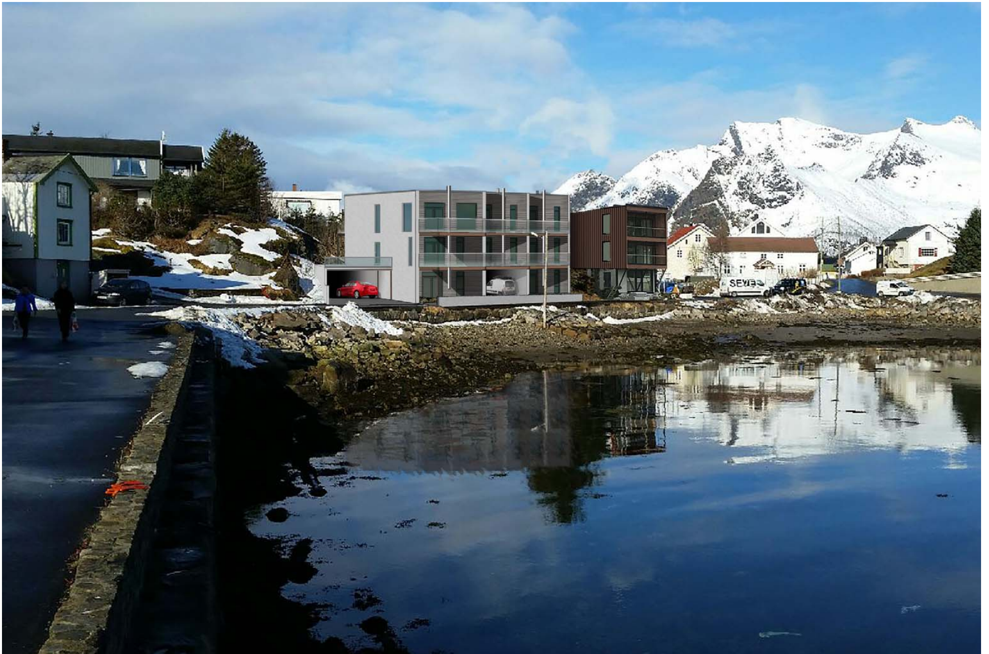
Arktos Arkitektur AS - Utbygging Steinvegen 6 Kabelvåg - sett fra moloen
