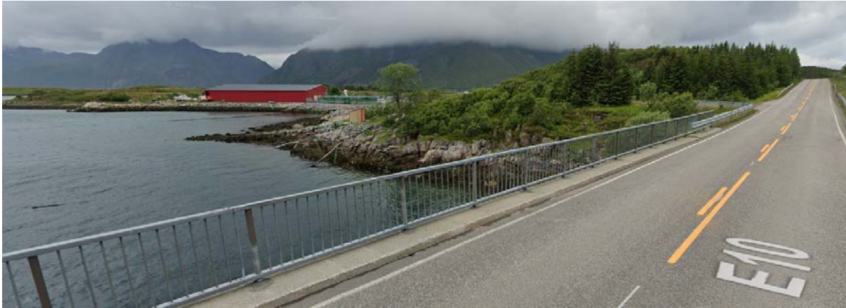
Figur 10: "Gatebilde" over området sett mot nordvest fra brua på Ev. 10. Bildet viser blokkstein/berg i strandsonen. [Kilde: google.no/maps]
