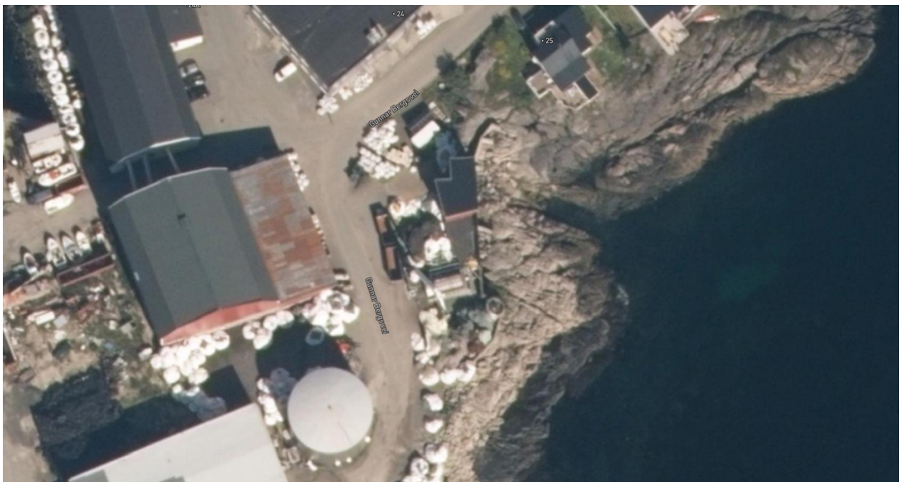
Figur 8 - Lagring av material nært veien og i frisiktsonen, kranen ca. i midten av bildet, manglende veikant og fortau.
