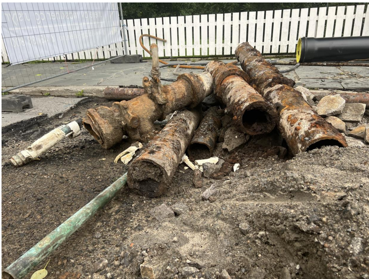
Gamle rør fra Storgata (Bilde: Stig Rune Dybwig).
