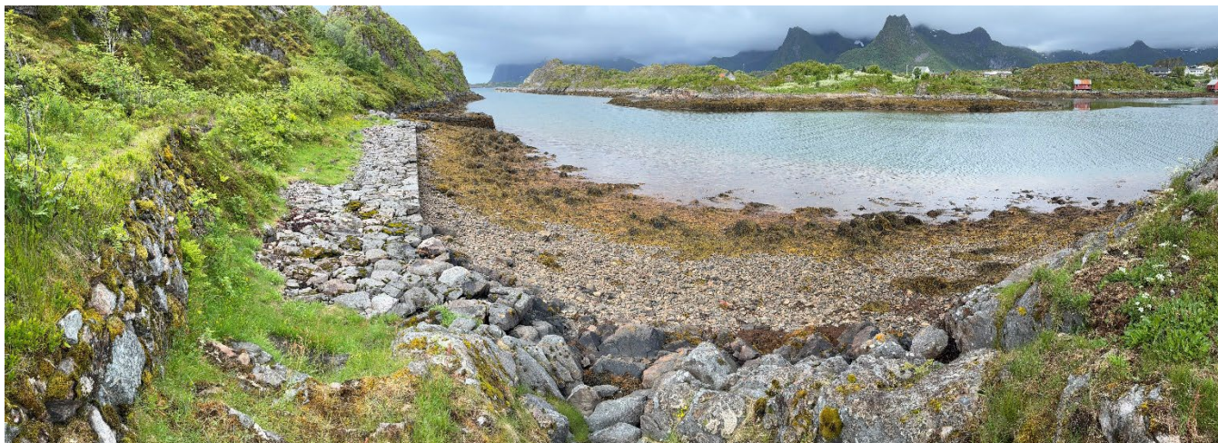
Fig. 7. Oversikt på gamle steinkaianlegg i planområdet sett fra østenden (mot V).
