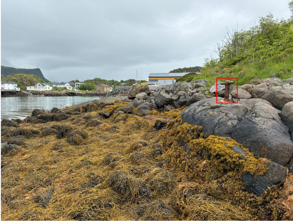
Fig. 13. Utsikt over fjæra i planområdet øst for steinkaifundamentet med en forøyningsbolt (T-bolt).
