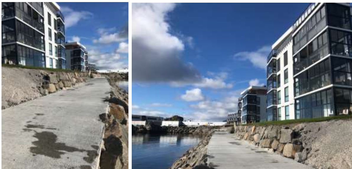
Fyllingsfront og havnepromenade ved nylig oppførte boligblokker sett mot sørvest
