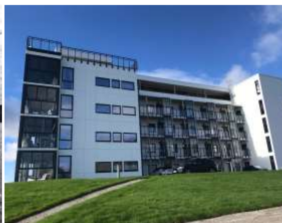
Fasade nordøst av nordligste boligblokk på Purkholmen
