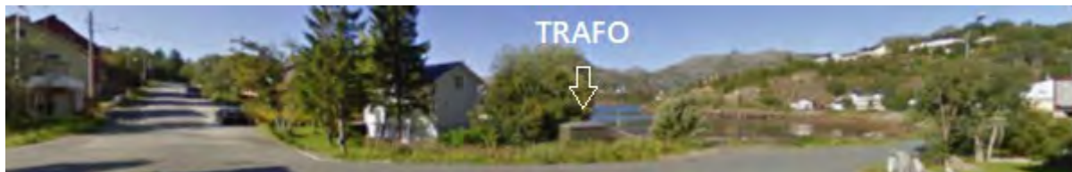
FIGUR 17: FOTO NETTSTASJON. KILDE GOOGLE MAPS.
