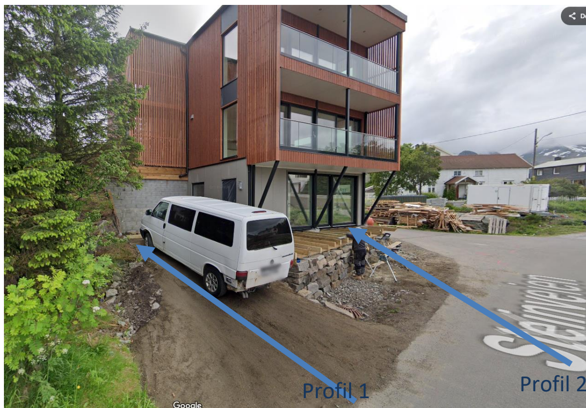
Figur 6 Fasade mot sjø. Profil 1 og 2 inntegnet. Foto: google street view.
