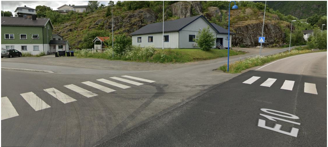
Figur 8 Bilde som viser dagens kryss. (Google maps).
