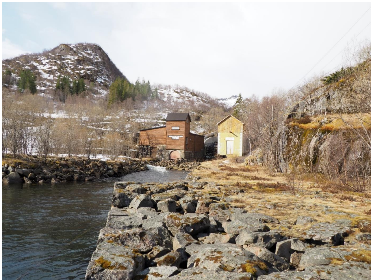
Figur 5-10: Leirosen kraftverk sett fra nordøst. Maskinhuset og dieselhuset er delvis bevart (befaringsfoto, mai 2021).
