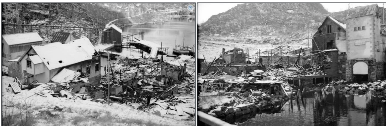
Figur 5-4: Guanofabrikken og kraftstasjonen etter brannen i 1956. Bildet til høyre viser kraftstasjonen med den utbrente maskinistboligen ved siden av (kilde: digitaltmuseum.no).
