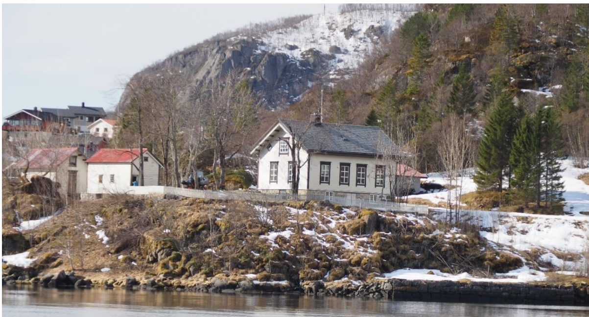
Figur 5-13: Bestyrerboligen og uthus fotografert i 2021. Hovedhusets uttrykk mot sjøen er i stor grad bevart (befaringsfoto, mai 2021).
