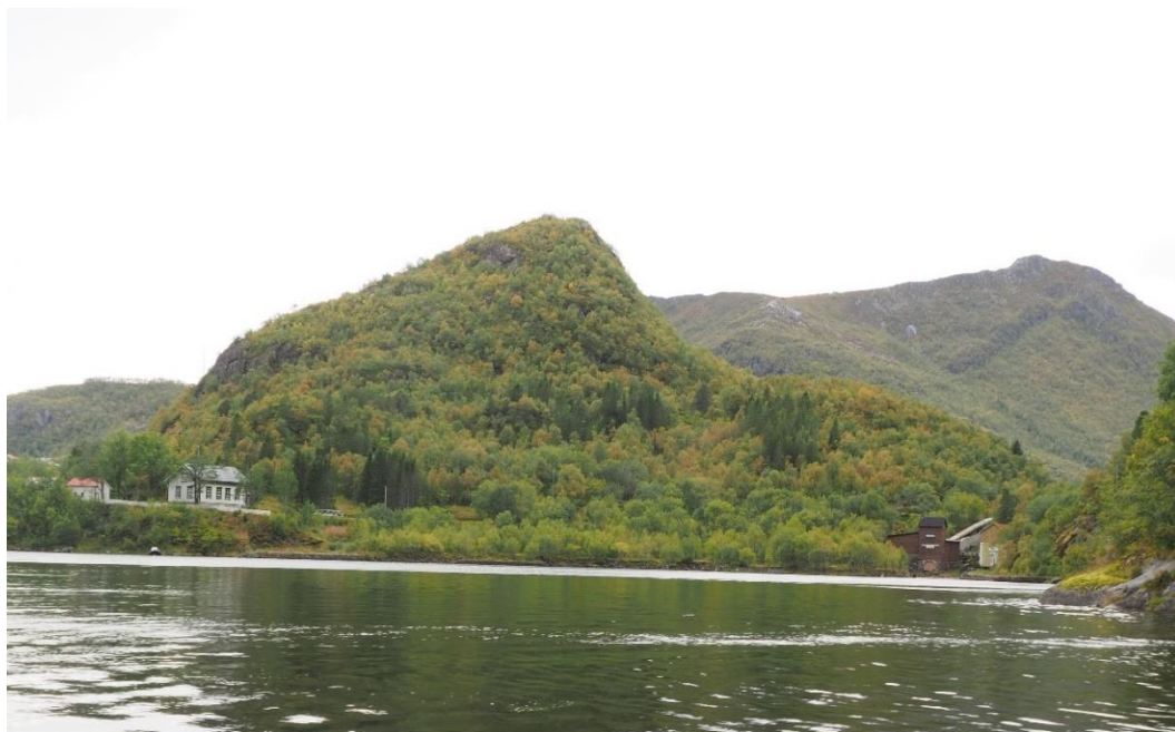
Figur 5-2: Delområdet slik det framstod i september 2021. Bestyrerboligen til venstre og kraftstasjonen til høyre i bildet (befaringsfoto).
