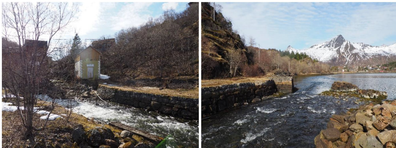
Figur 5-11: Murfundamenter ved utløpet av Leiroselva nedenfor kraftstasjonen. Til høyre ses rester av fundamentene for utskipningskaia (befaringsfoto, mai 2021).
