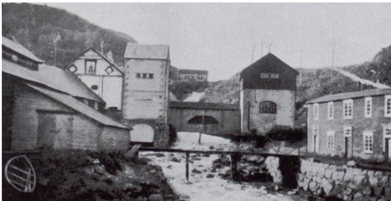
Figur 5-8: Kraftstasjonen i Leirosen. Fra venstre mot høyre ses guanofabrikkens produksjonslokale, maskinistboligen, maskinhuset, damhuset (bak), hus for reservemaskinen (dieselhuset) og smia. Bak til høyre skimtes renna for transport av isblokker fra Lille Kongsvann (5).
