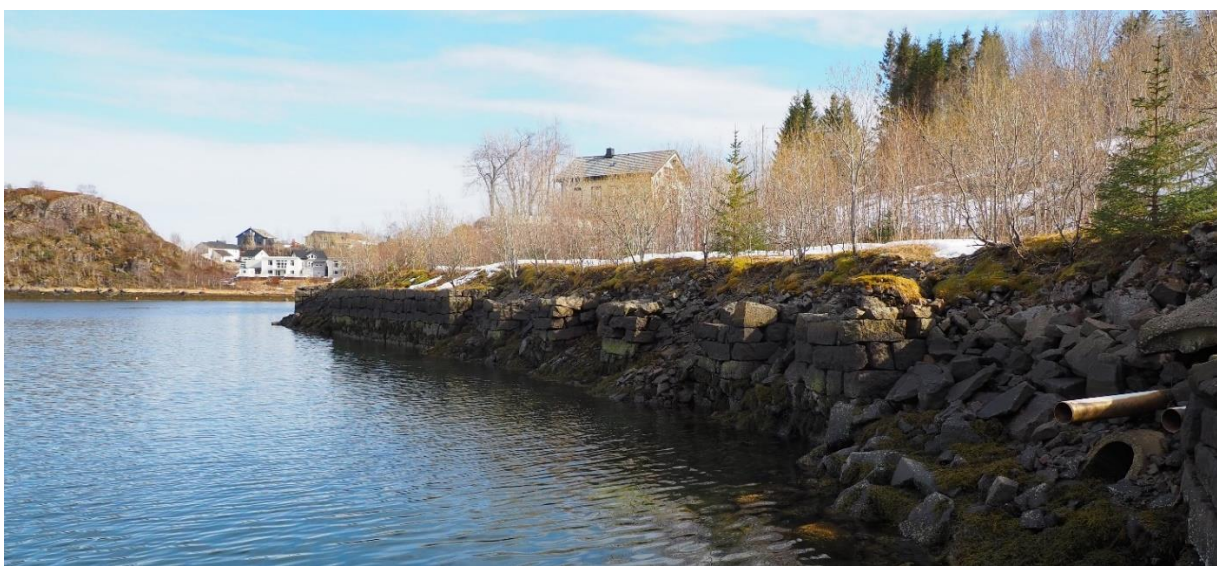
Figur 5-6: Rester av fundamenter etter kaianlegg og «nybrygga» ved guanofabrikken (befaringsfoto, mai 2021)
