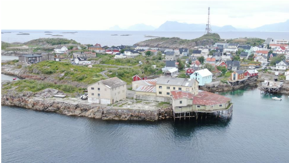
Dronefoto av Fredriksenbruket med omkringliggende bebyggelse, tatt i juni 2021 før riving av sløyeskurene.
