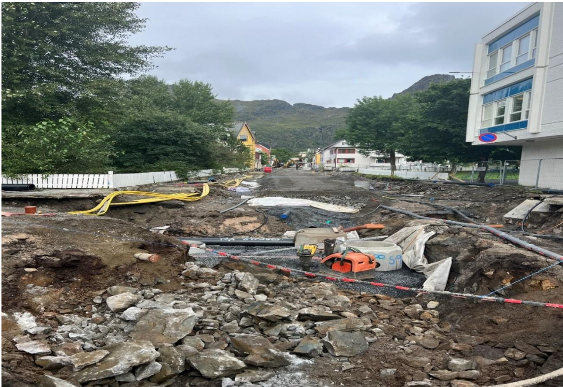
Øverst: Arbeid med Storgataprojektet / Under: Gamle vannrør som skiftes ut
