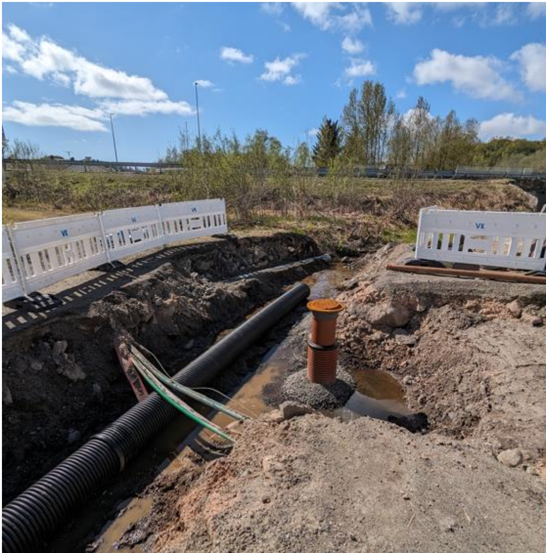
Figur 1 Parkeringsplass Ungdomsskoleveien Kabelvåg
