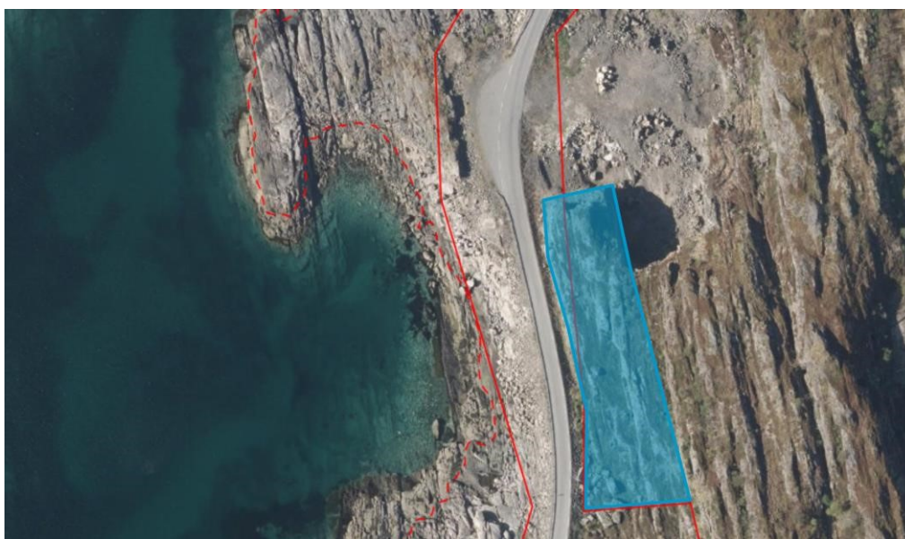
Område på ca. 2600 m 2 for uttak av masser til nytt fortau.
