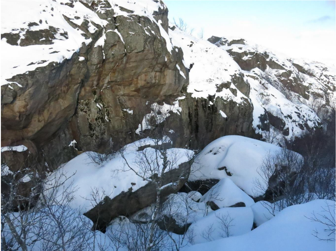
Bilde 6. Eksempel av overhengende bergparti med gamle bergblokker i underkant, samt sprekkeavløste blokker i bergskrånningen. Bildet tatt ved byggeområde nr. 4 (se figur 2).
