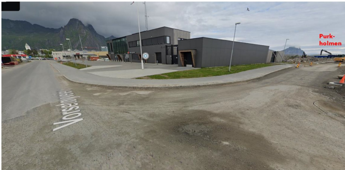
Bilde 1 Vorsetøyveien sett inn mot Purkholmen og nordover mot sentrum. Kilde: Google Streetview 2019
