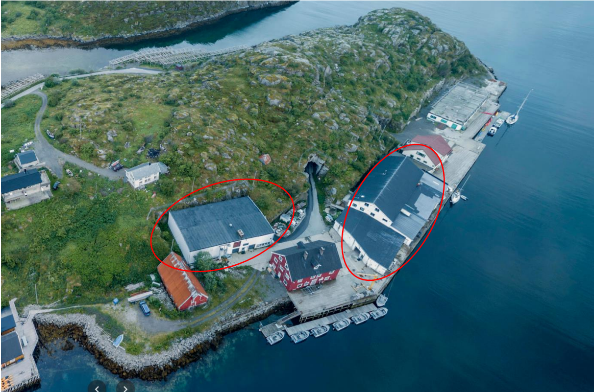
Figur 5 Bebyggelse på Kuholmen med tilnærmet flate tak
