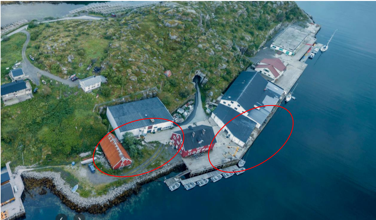
Figur 6 Bebyggelse på Kuholmen med tilnærmet flate tak
