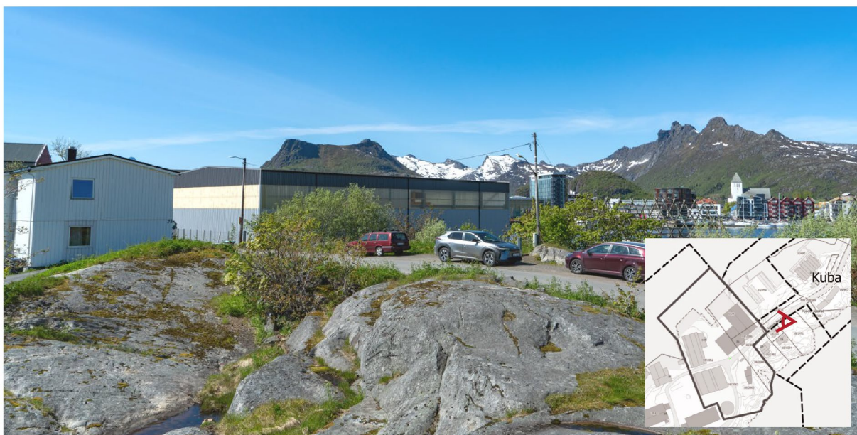
Figur 14 Eksisterende boligbebyggelse til venstre i bildet. Foto fra 2023, eksisterende situasjon.
