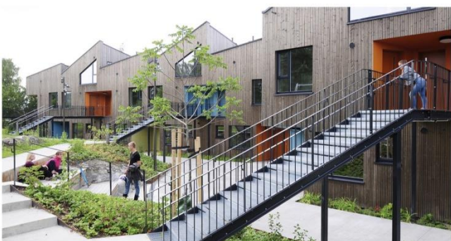
Ulsholtveien 31, Haugen / Zohar Arkitekter
