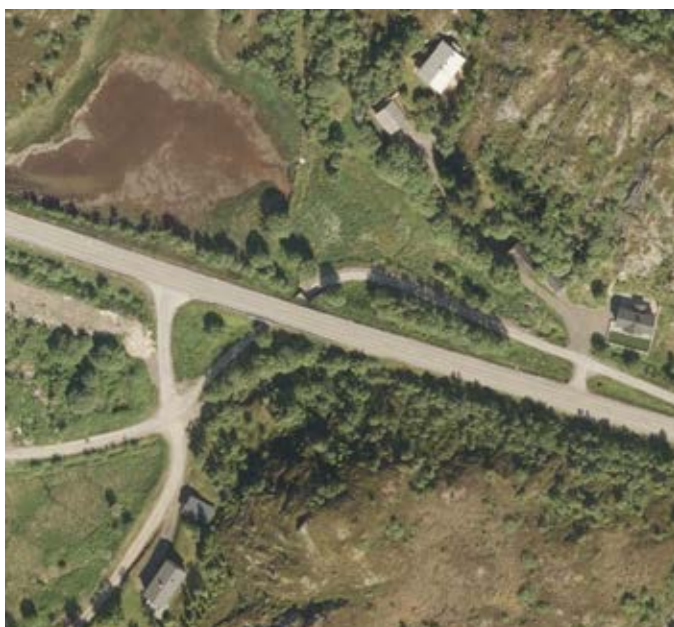
1. Planfri krysning av E10 - før Eidet
