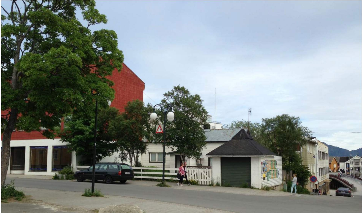
Figur 9 - Foto fra Vestfjordgata mot planområdet (Vindveggen)
