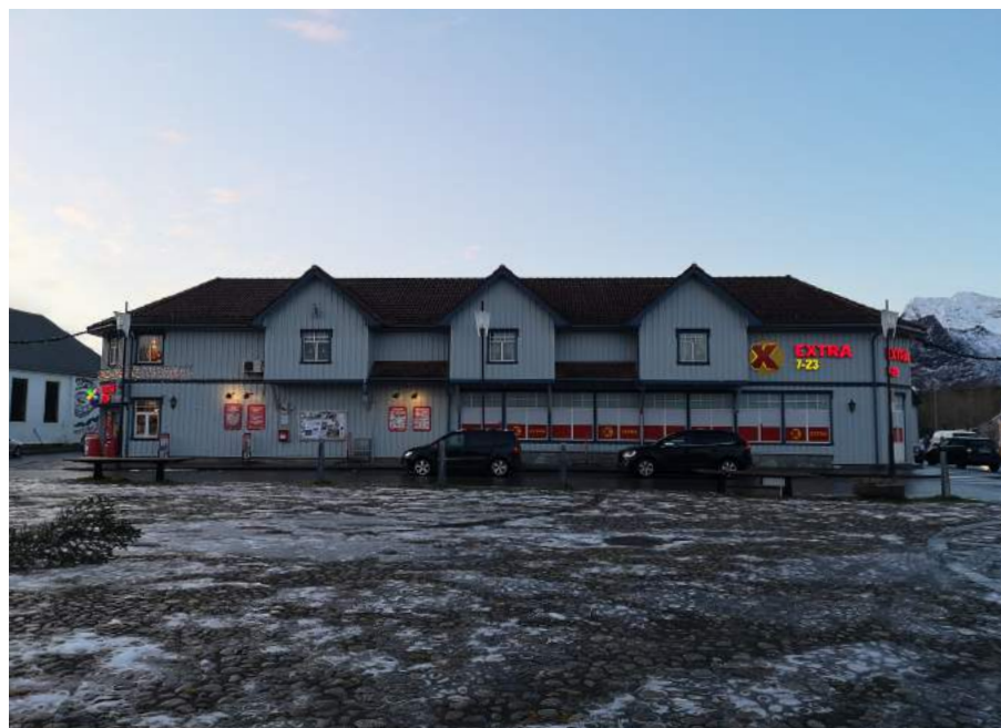
Strakstiltak med fjerning av folie i vinduene på coop, for å gi mer åpen fasade mot torget.
