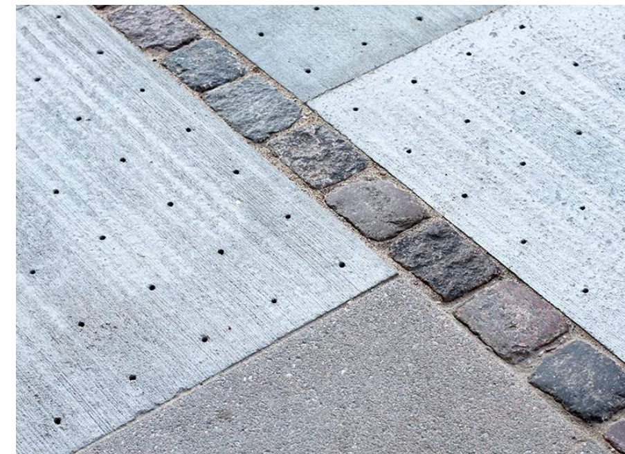
Investeringer gjort på overflaten fremfor nedgravde løsninger er god økonomi. Foto hentet fra tredjenatur.dk viser permeable dekker som drenerer overvann.
