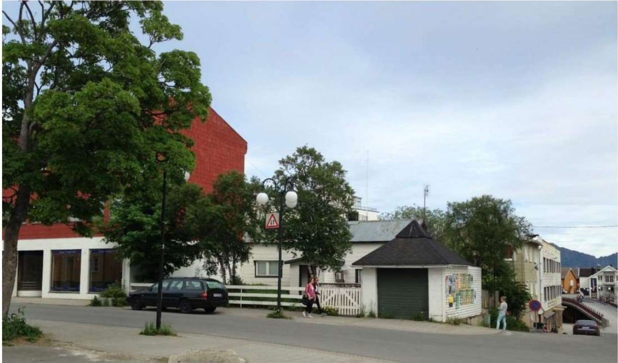
Figur 9 - Foto fra Vestfjordgata mot planområdet (Vindveggen)
