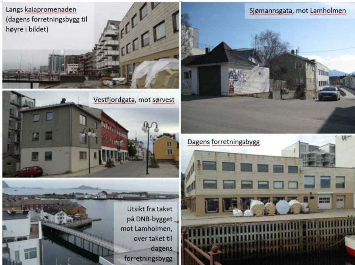
Figur 5 - diverse fotos, Vindveggen
