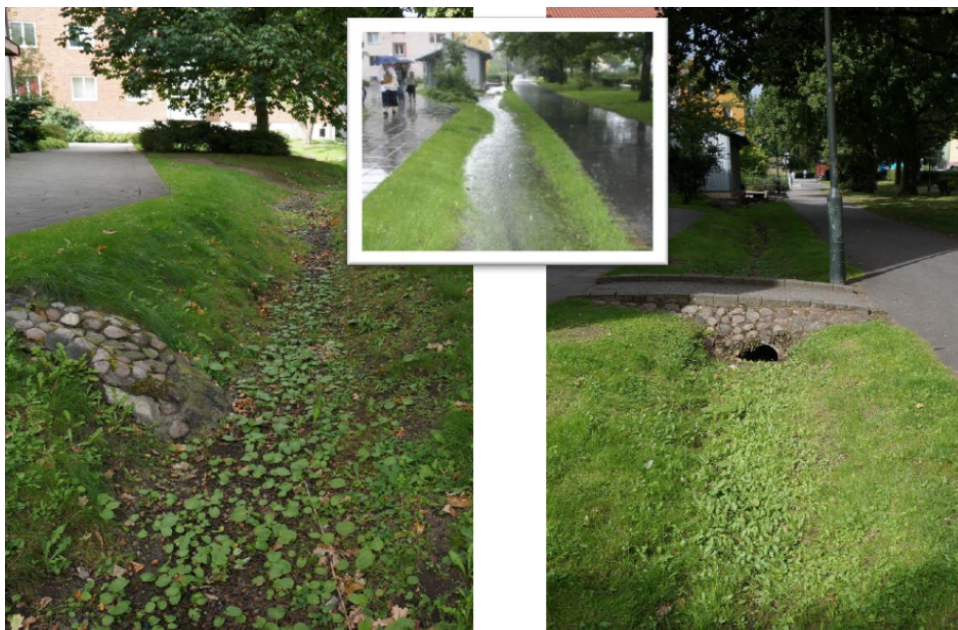
Figur 9. Vadi (åpen renne eller grøft). Fotomontasje: Oslo kommune, VAV, fra rapporten «Studietur i København og Malmø. Aktuelle tiltak for håndtering av overvann i Oslo».
