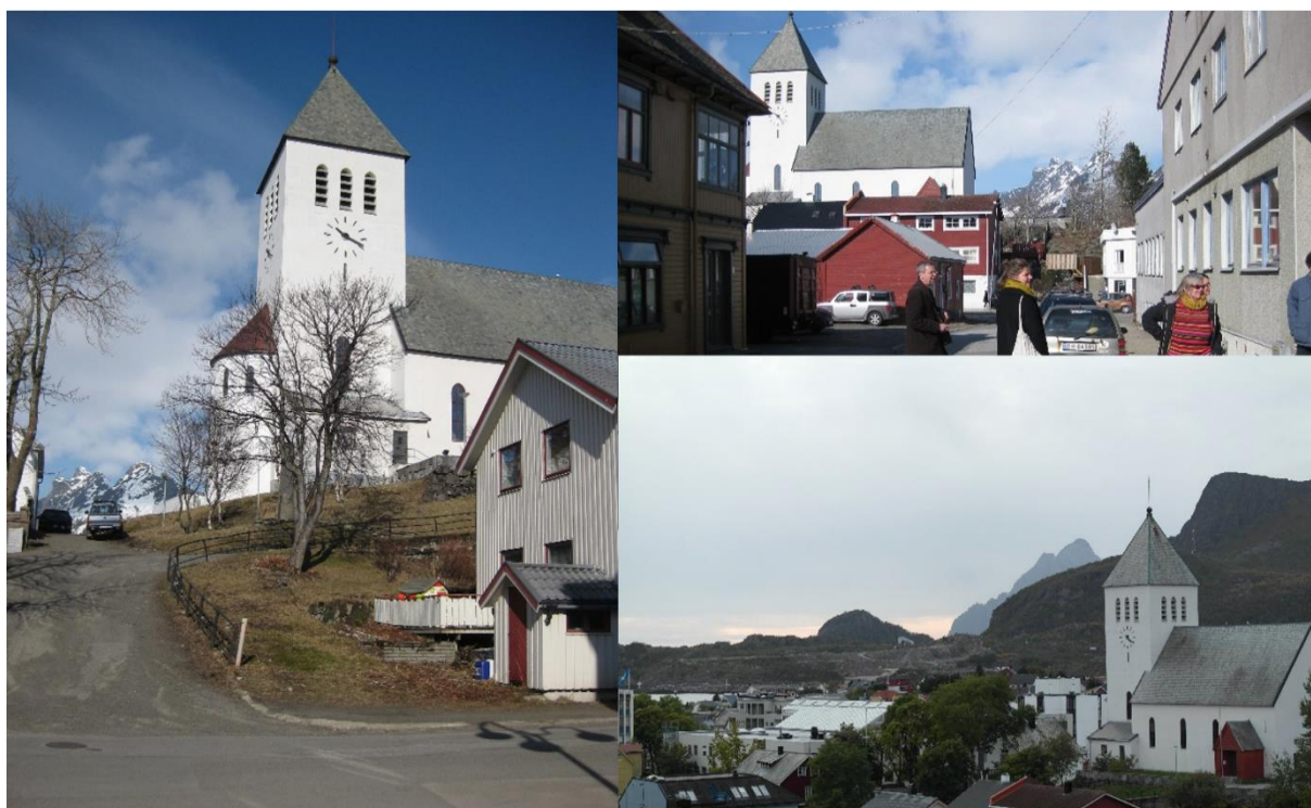
Figur 4 - Svolvær kirke på Langåsen beliggende 12 moh. er fra 1934 og framstår som et naturlig siktepunkt fra flere retninger.
