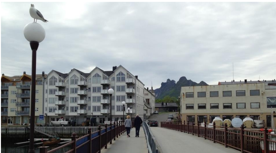
Figur 13 - Et prosjekt som bygger på gjeldende planer med kvartalsstruktur på inntil 6 etasjer gir ikke spesielt negative konsekvenser i forhold til sikt til Svolvær kirke.
