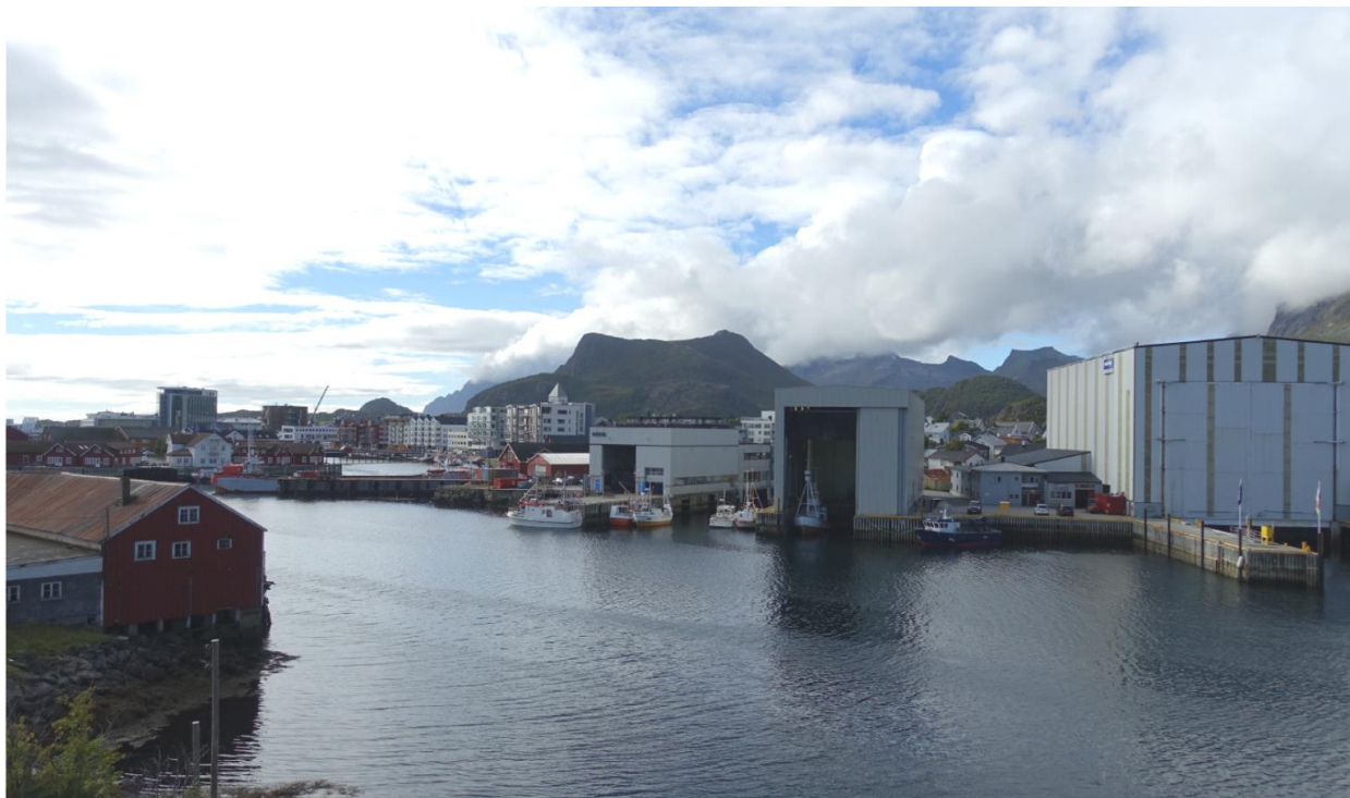
Figur 1 - Fotografi mot Svolvær sett fra Svinøybroa (Vindveggen)
