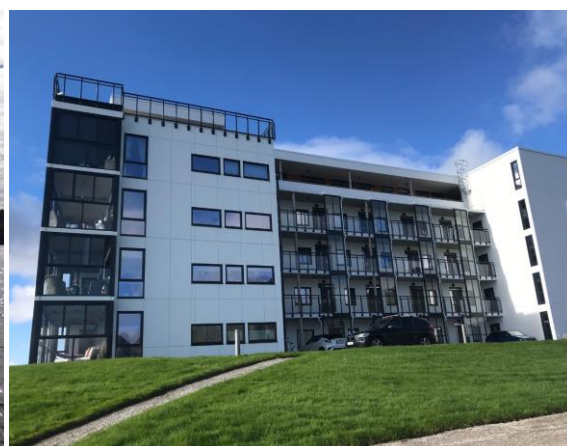
Fasade nord av nordligste boligblokk på Purkholmen
