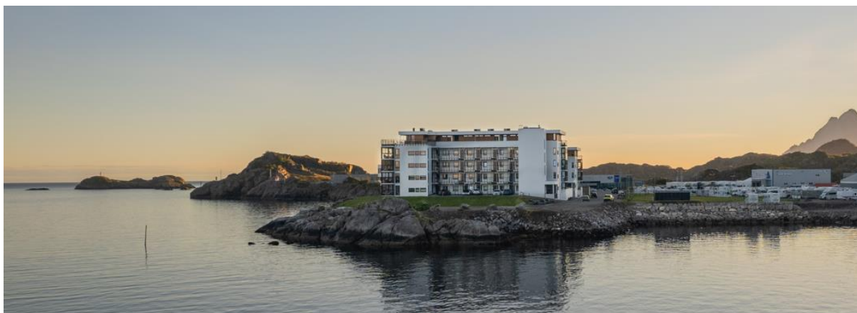
Foto av dagens situasjon med stolpe som avgrensar ferdsel i sjø
