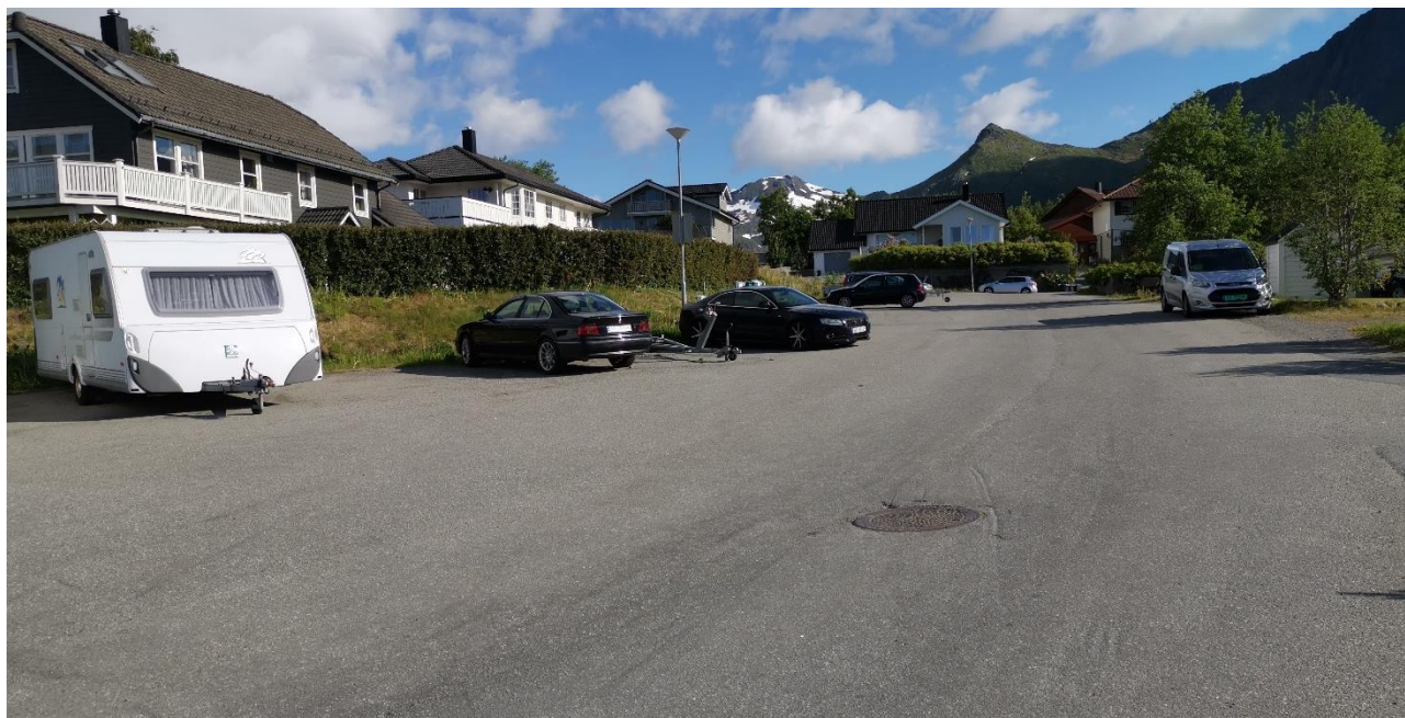
Figur 16: Offentlig parkering ved Lundeveien 4/6, synsretning øst. (Foto tatt på befaring, Norconsult, 2020-07-03)
