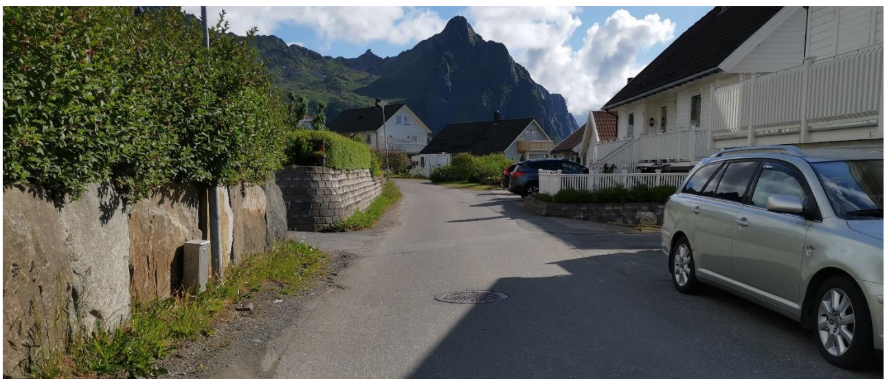
Figur 13: Lundeveien, synsretning øst. (Foto tatt på befaring, Norconsult, 2020-07-03)
