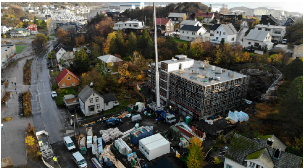
Figur 6 Foto fra forslagsstiller som viser leilighetsbygget med teknisk rom/heissjakt noe høyere (kote 24,5) enn bod/trapperommet (kote 23) på taket.
