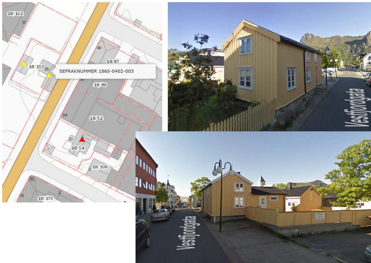
Figur 3 - Kartutsnittet til venstre ovenfor viser Gärtners Minde i Askeladdens register. Bildene til høyre (google maps) viser kulturminnet fra Vestfjordgata, hhv. fra sørvest og nordøst. Kirken skimtes i bakgrunnen i nederste bildet.
